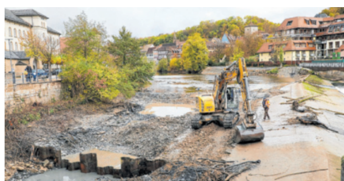
Alles ist im Fluss, sogar der Bagger. Um eine Fischaufstiegshilfe an der Weilerwiese anzulegen, wird eine Spundwand entfernt. Der Wasserspiegel des Koachers sinkt nun weiter. Foto: Ufuk Arslan
