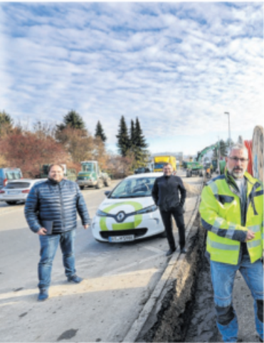
Die Stadtwerke verlegen in der Carl-Zeiss-Straße Leerrohre fürs Breitband. Foto: Thomas Kiehl
