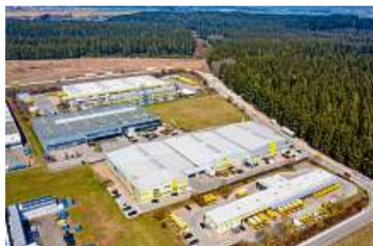
Oben ist schon die Schneise für die geplante Trasse zu sehen. SF-Filter ist das dritte Gebäude darunter. BILD: HANS-JÜRGEN GÖTZ
