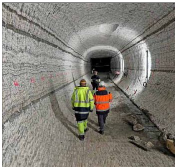
Tests zur Versiegelung der Deponie gab es bereits.
