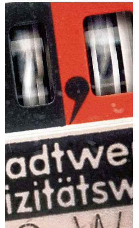
Der Gaszähler läuft und läuft.
