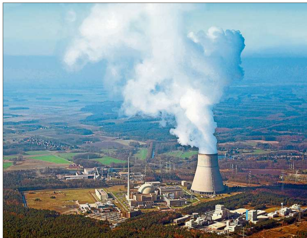
Im Atomkraftwerk Emsland in Niedersachsen soll Ende 2022 definitiv Schluss sein mit der Stromproduktion. Foto: Gentsch
