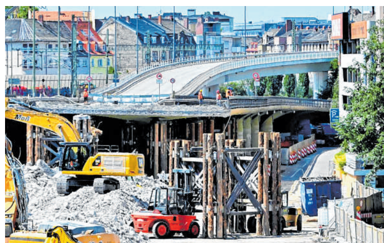
Die Stützen aus Holz spielen eine wesentliche Rolle im Verfahren. BILD: ACHIM KEIPER
