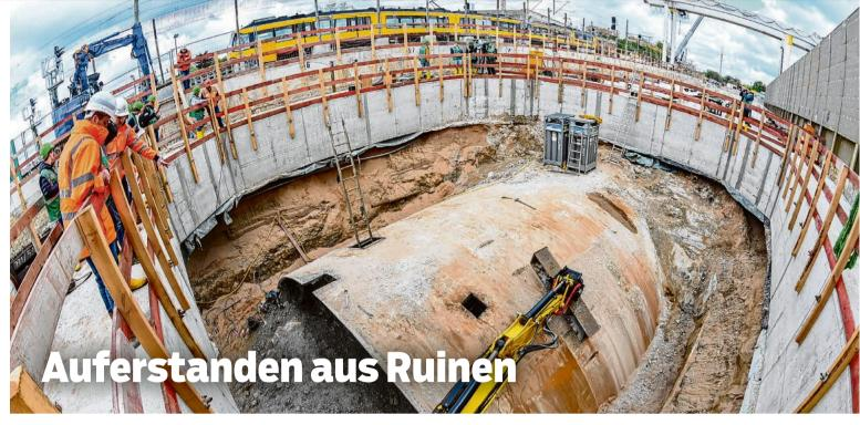
Fast sieben Jahre steckte sie unter der Erde fest - und wird nun freigelegt: Nach einer spektakulären und folgenreichen Havarie im Jahr 2017 in einem Tunnel unterhalb der Rheintalbahn sind erste Teile der damals verschütteten und einbetonierten Tunnelbohrmaschine "Wilhelmine" wieder zum
