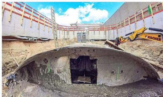
Ein kleiner Teil der im August 2017 havarierten Tunnelvortriebsmaschine „Wilhelmine“ ist bereits in der Baugrube zu sehen. Foto: Uli Deck/dpa
