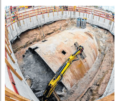
Blick auf einen Teil der freigelegten Tunnelbohrmaschine. BILD: ULI DECK/DPA
